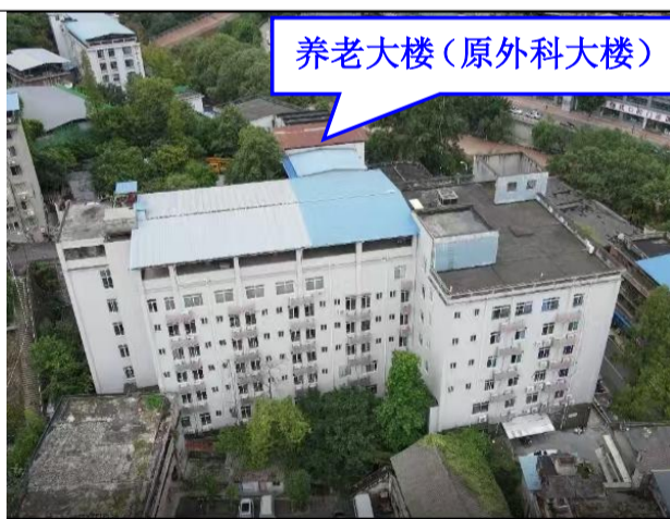
院区养老大楼现状
