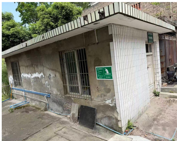
院区已建污水处理站
