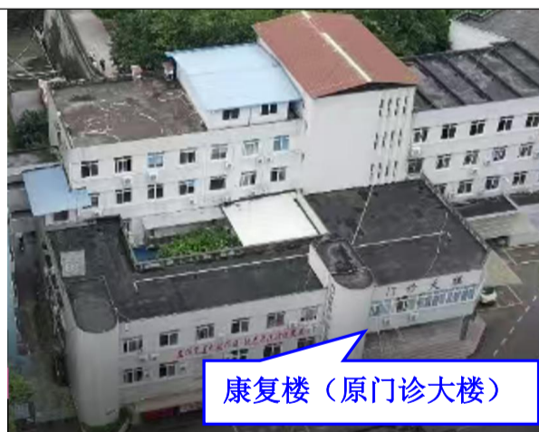
院区门诊大楼现状
